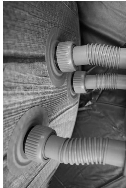
12. Innere Merkmale: Wasserzirkulationsauslass, Filteranschluss und Ablassschraube.
